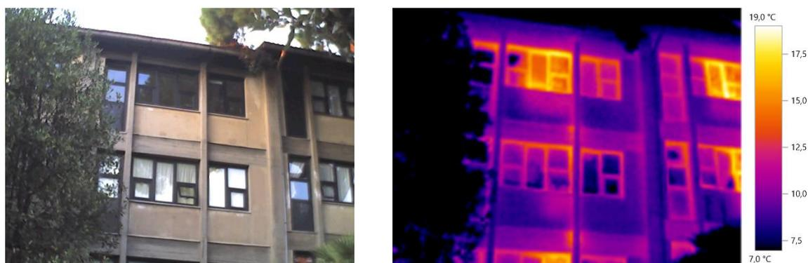
Come per l'involucro opaco, non è stato possibile ricavare dalla sola termografia informazioni circa la possibile trasmittanza termica degli elementi vetrati; si sono quindi "ricostruiti" gli elementi rilevati su appositi software di simulazione (EC700) ricavando così i valori di trasmittanza termica per ogni tipologia di serramento individuata in fase di sopralluogo. I risultati sono riportati nella Tabella 4.2 di seguito riportata.
